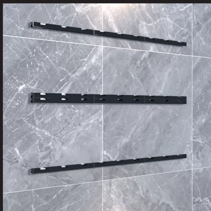
アルミプレートを壁に固定
